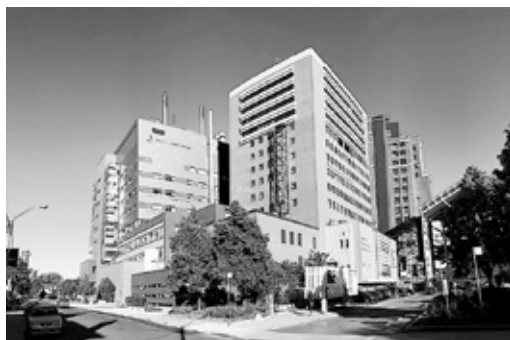
写真1：Toronto Western Hospital（右）とKrembil Discovery Tower（左）
