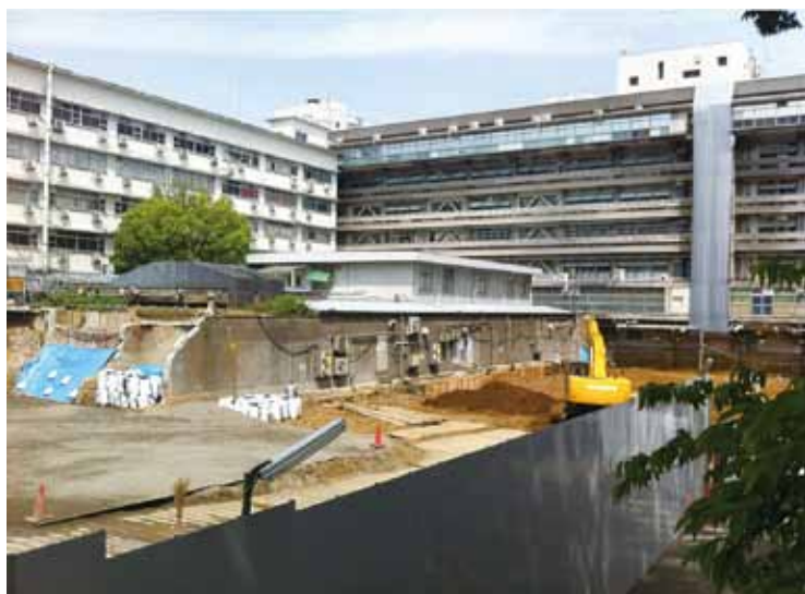
6号棟解体工事の写真。写真左が7号棟。真ん中から右が中央棟。 シートに覆われている部分が6号棟連結部。
