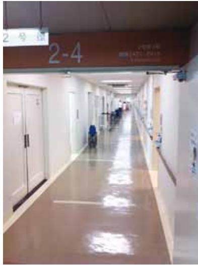
耐震補強が施された2-4病棟
